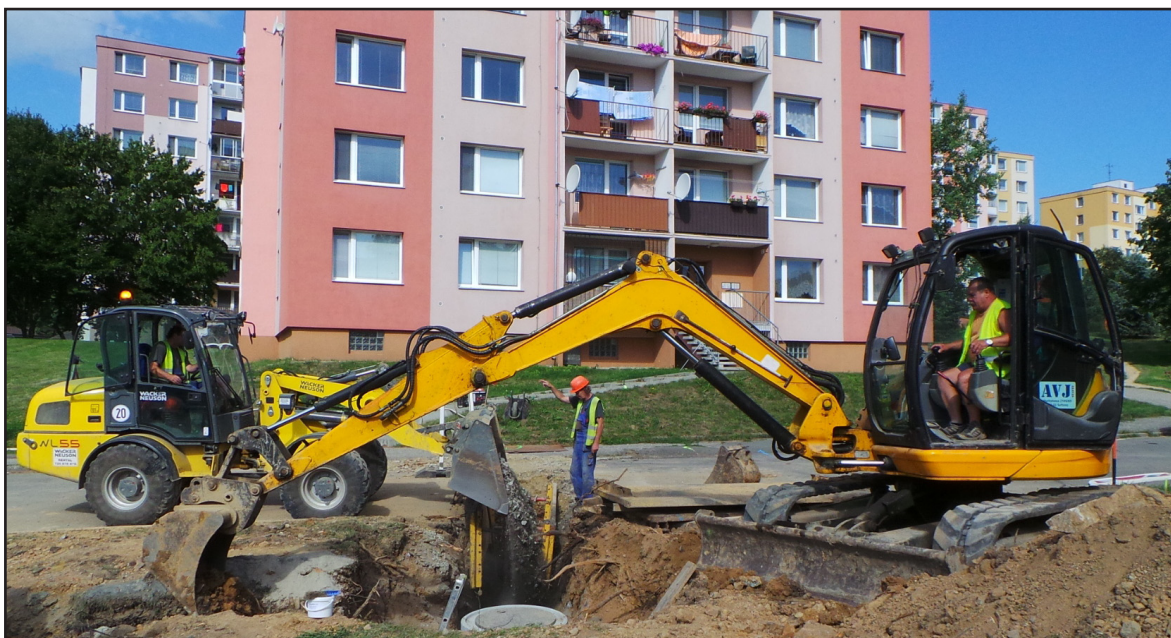
„Stavební úprava splaškové a dešťové kanalizace, ul. Převídzská, k.ú. Šumperk - etapa 5“
